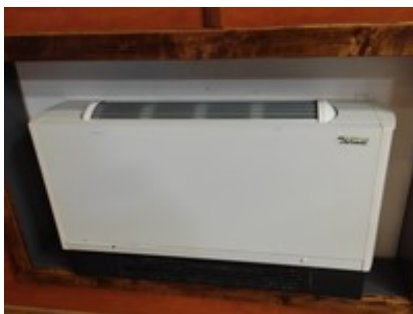
Slika 5 Slike ventilokonvektora
